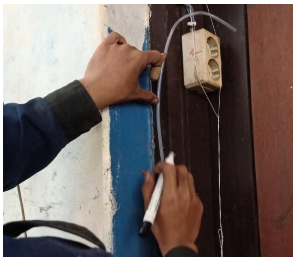
Gambar 38. Melakukan waterpass
