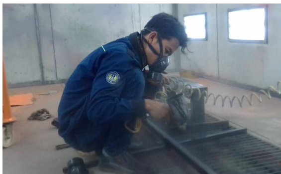
Gambar 37. Proses pengecatan menggunakan spray gun
