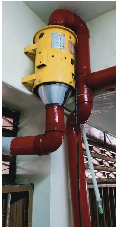
Gambar 15. Menguji ketahanan pipa saluran instalasi gas buang
