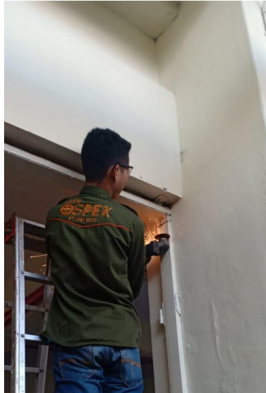
Gambar 9. Pemotong besi pada tembok bengkel
