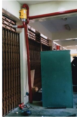
Gambar 8. pemasangan exhaust blower di dinding bengkel
