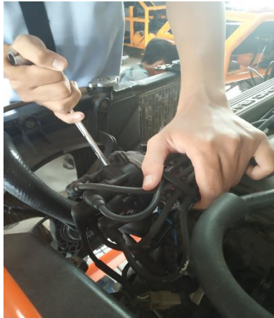
Gambar 25. Melepas baut pengikat rumah distributor
