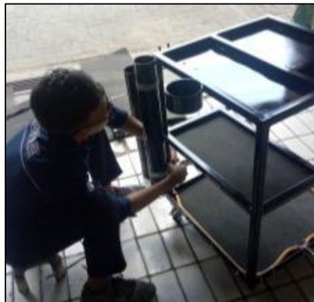
Gambar 22. Pemasangan pipa pelindung selang air impact dan air gun
