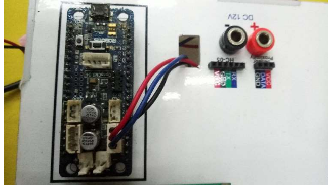
Gambar 10. Instalasi Kabel 3 Polig
