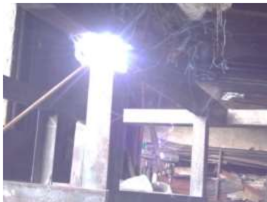
Gambar 28. Pengelasan Rak pada Rangka Meja Kerja Overhaul
