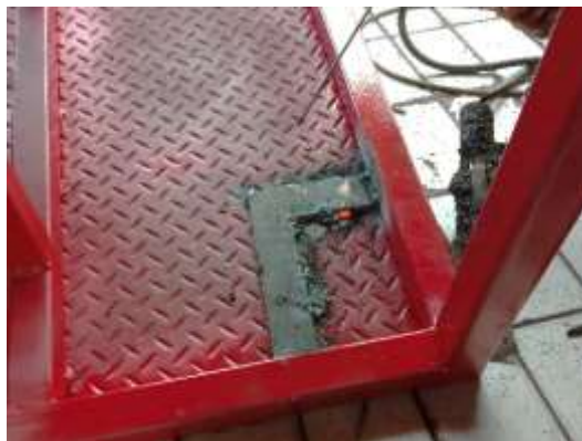
Gambar 32. Pengelasan Dudukan Ragum pada Meja Kerja Overhaul
