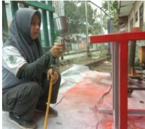
Gambar 31. Pengecatan Meja Kerja Overhaul
