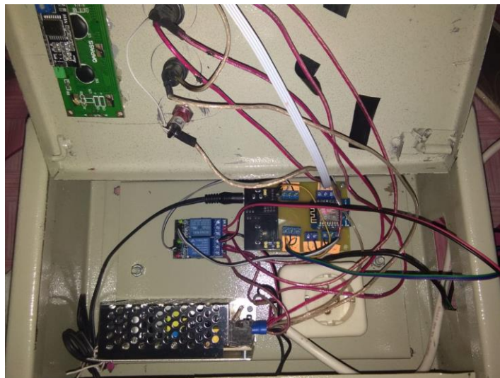
Gambar 19. Pemasangan Elektronik pada Box Panel
