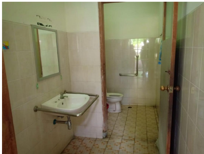
Gambar 56. Bagian Dalam Toilet (Sumber: Dokumentasi Pribadi, 2019)
