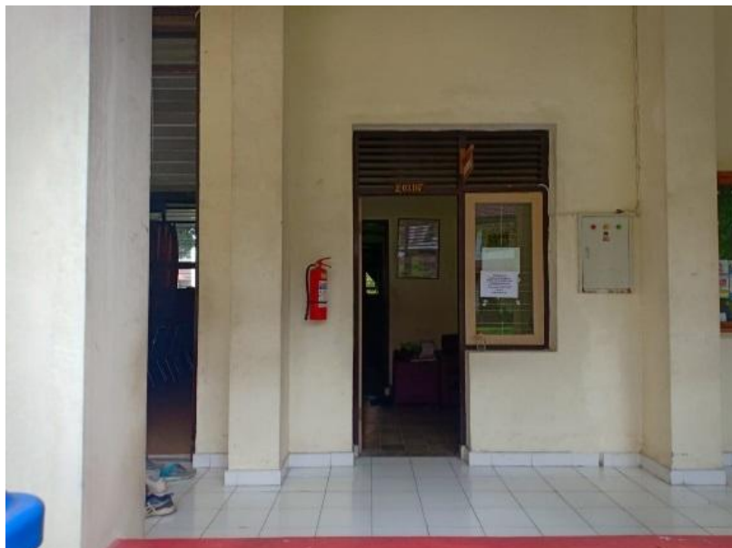
Gambar 33. Pintu Tunggal Gedung Kuliah Lantai 1 (Sumber: Dokumentasi Pribadi, 2019)
