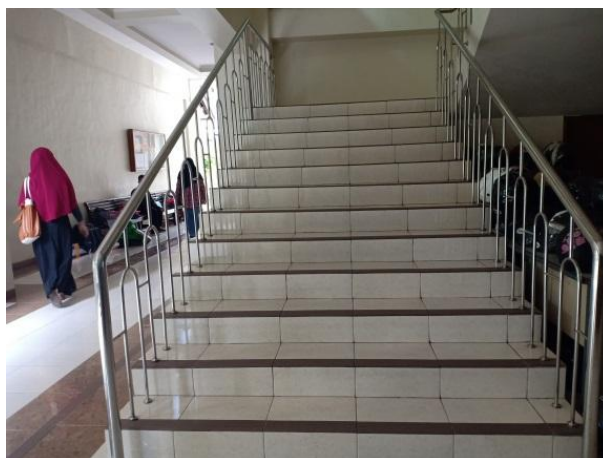
Gambar 46. Tangga Gedung Dekanat (Sumber: Dokumentasi Pribadi, 2019)
