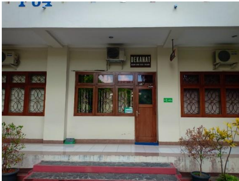
Gambar 32. Pintu Tunggal Gedung Dekanat Lantai 1 (Sumber: Dokumentasi Pribadi, 2019)
