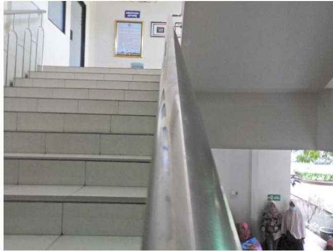
Gambar 47. Handrail Tangga Gedung Dekanat (Sumber: Dokumentasi Pribadi, 2019)
