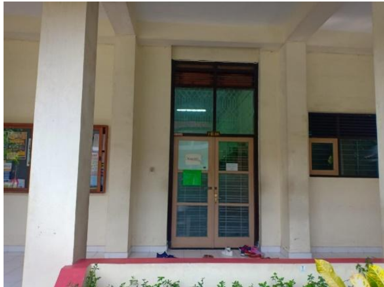
Gambar 34. Pintu Ganda Gedung Kuliah Lantai 1 (Sumber: Dokumentasi Pribadi, 2019)
