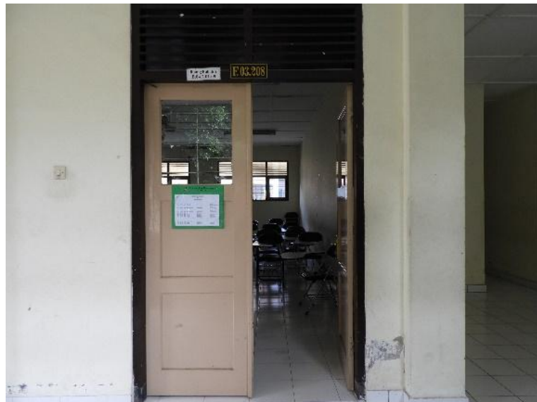
Gambar 35. Pintu Ganda Gedung Kuliah Lantai 2 (Sumber: Dokumentasi Pribadi, 2019)
