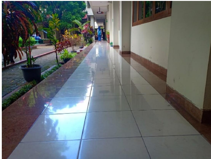
Gambar 38. Selasar Gedung Dekanat lantai 1 (Sumber: Dokumentasi Pribadi, 2019)
