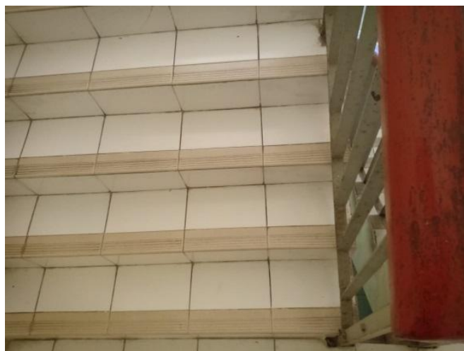
Gambar 48. Antrid, Oprid, dan Step nosing Tangga (Sumber: Dokumentasi Pribadi, 2019)
