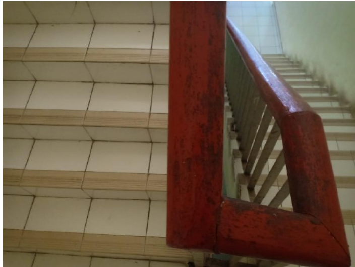
Gambar 52. Handrail Tangga Gedung Kuliah (Sumber: Dokumentasi Pribadi, 2019)
