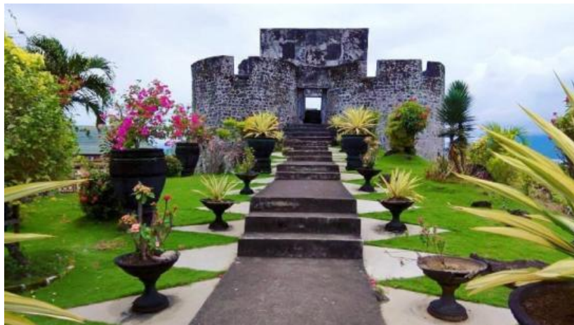
Gambar 2 Bangunan Benteng Tolukko
