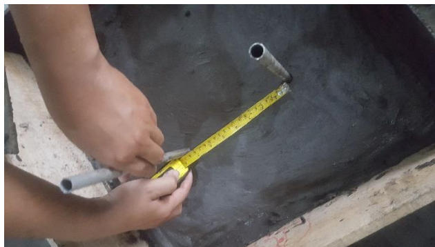
Pengukuran jarak drainase kolom pasir vertikal
