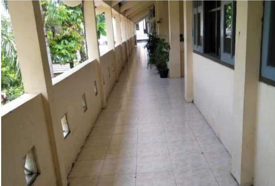
Gambar 29. Kondisi Sirkulasi Horizontal (Sumber: Pengamatan lapangan, 2019 )
