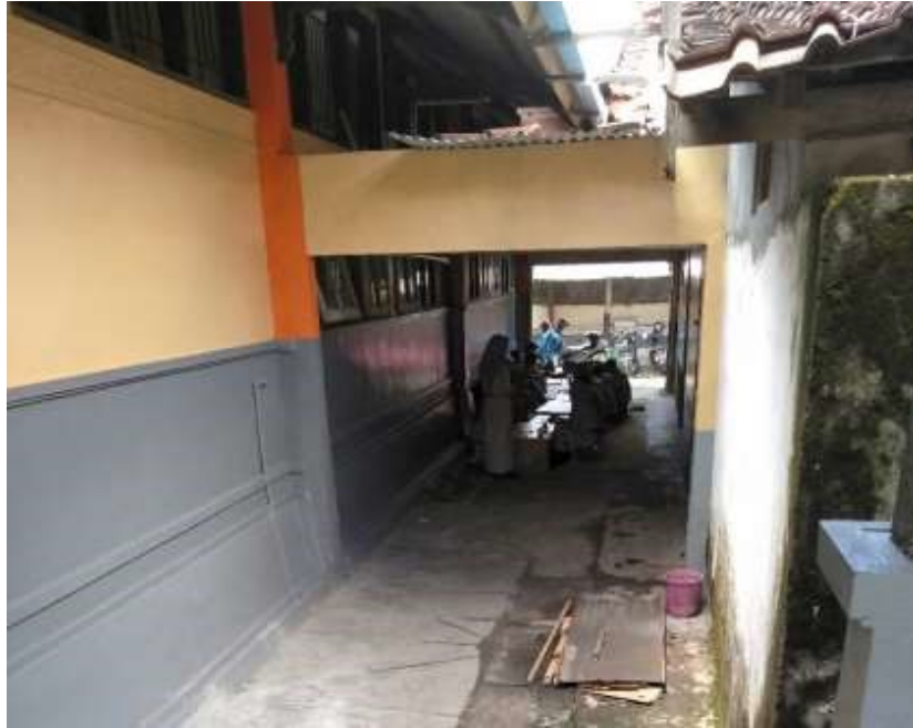
Gambar 27. Kondisi Sirkulasi (Sumber: Pengamatan lapangan, 2019)
