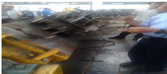
Gambar 22. Proses Koordinasi Permasalahan & Penanggulangan, atasan & Juru Las/Welder
