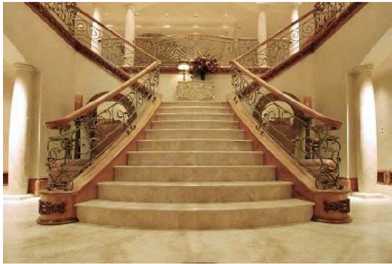
Gambar 16. Tangga Model Y (Sumber: PPPPTK BMTI, 2013)
