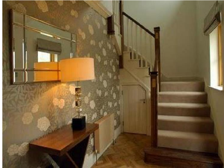
Gambar 14. Tangga Model L (Sumber: PPPPTK BMTI, 2013)
