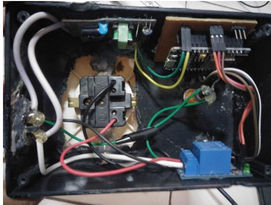
Gambar 18. Pemasangan Elektronik pada Box Control
