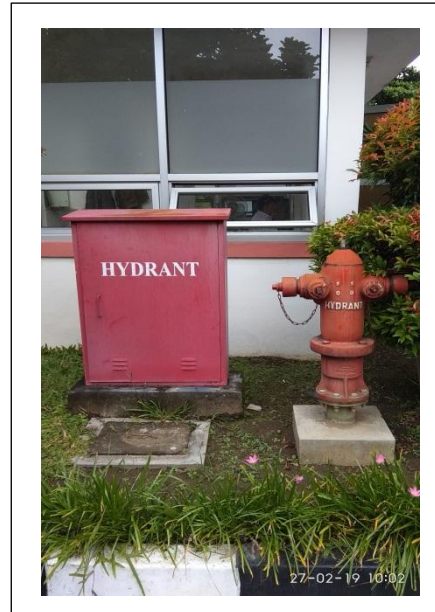
Gambar 96. Hydrant di luar gedung Sumber : Dokumentasi pribadi 2019
