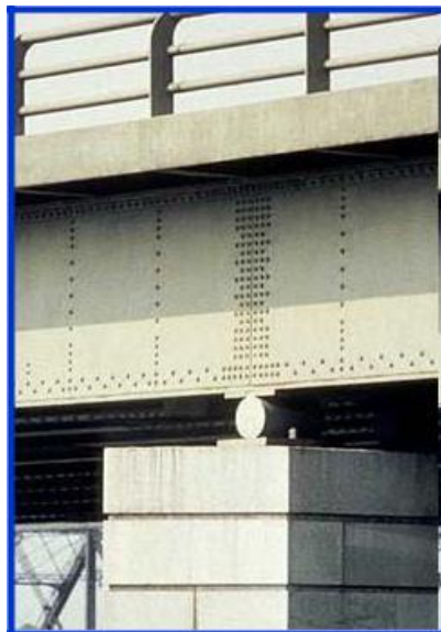
Gambar 4. Aplikasi tumpuan rol pada struktur atas jembatan
