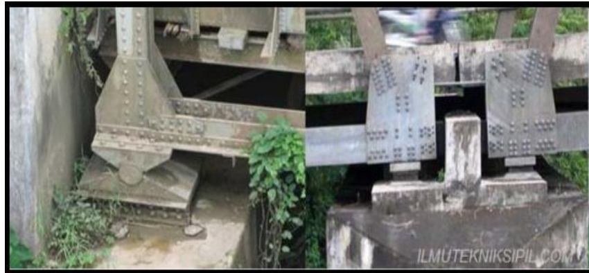
Gambar 2. Aplikasi tumpuan sendi pada struktur jembatan
