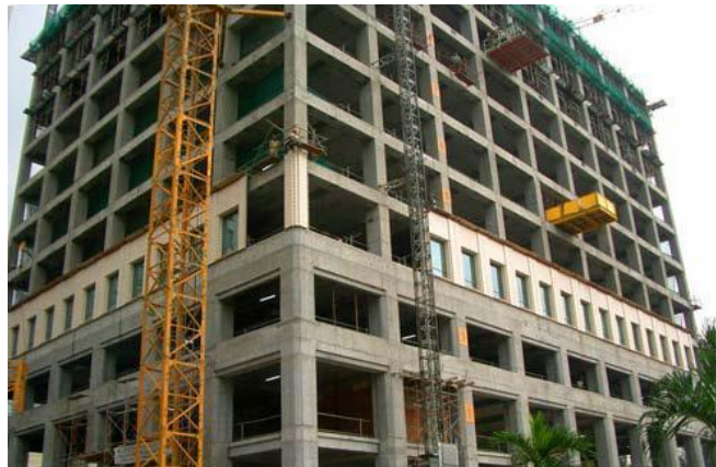
Gambar 6. Aplikasi jepit sempurna pada bangunan gedung berlantai banyak
