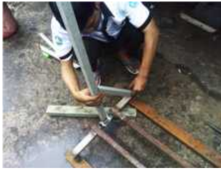
Gambar 39. Pengelasan pada Bagian Penyangga
