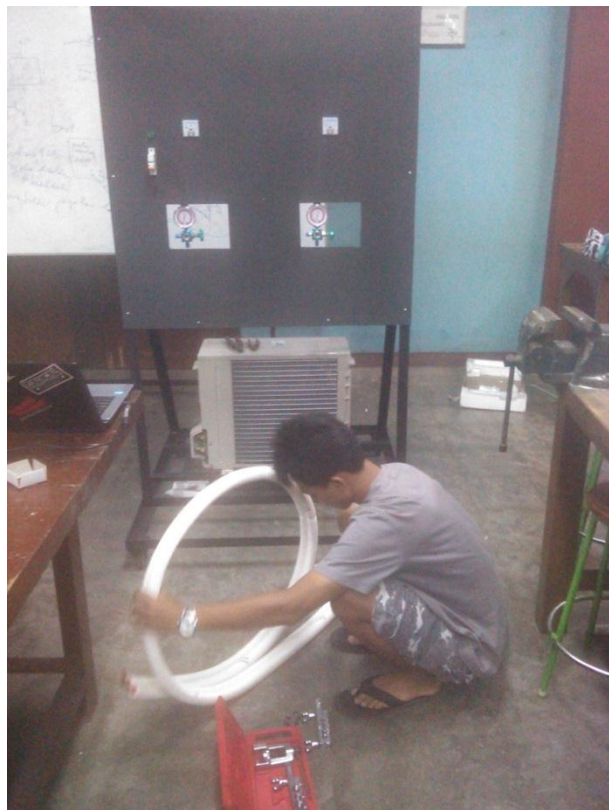
Peralatan yang digunakan untuk memasang pipa dan proses pemasangan pipa.
