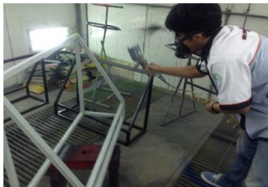
Gambar 26. Pengecatan Cat Primer
