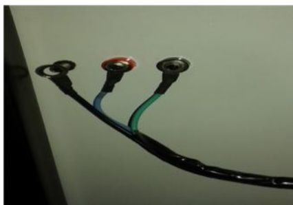
Gambar 30. Hasil Pemasangan Kabel dengan Stecker Bust
