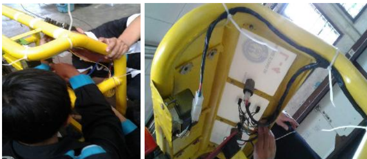
Gambar 48. Proses Pemasangan Komponen dan Kabel
