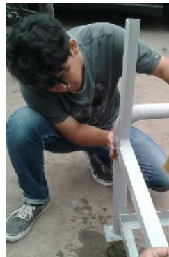
Gambar 45. Proses Menghaluskan Permukaan Lapisan Primer
