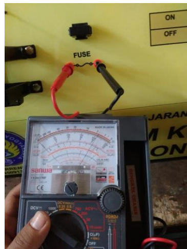
Gambar 58. Mengukur Kontinuitas Fuse
