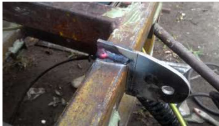
Gambar 42. Dudukan Pengait Kabel Pada Rangka Setelah Dilas
