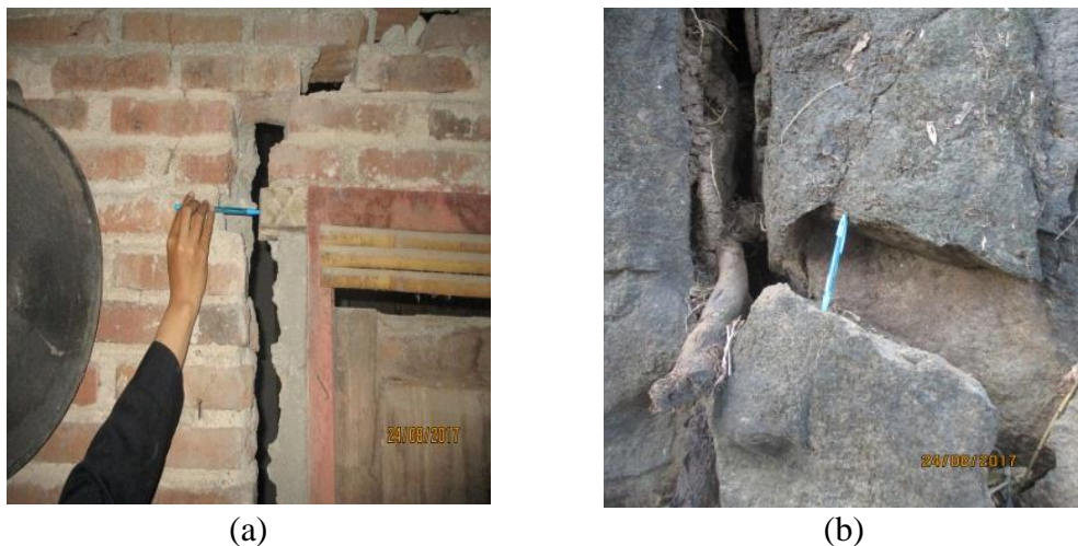
Gambar 26. Dampak gerakan tanah di titik D12 (a) keretakan pada dinding bangunan (b) deformasi batuan.
