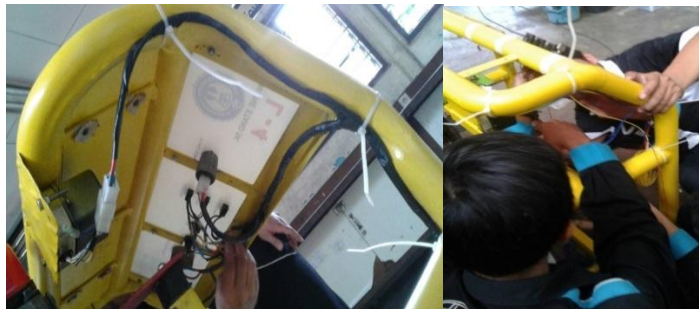
Gambar 69. Proses Pemasangan Rangkaian Kabel
