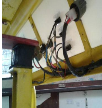
Gambar 79. Hasil Perangkaian Kabel Sistem Kelistrikan
