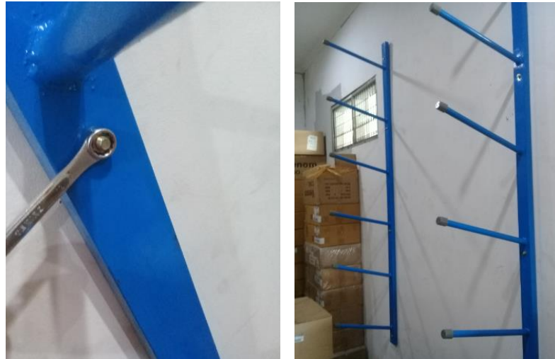
Gambar 38. Pemasangan Rak Bumper pada Dinding
