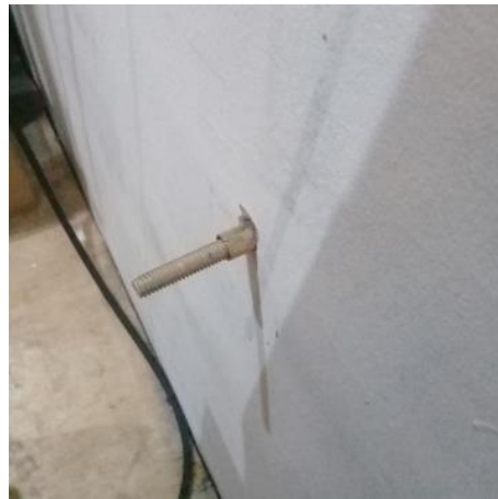
Gambar 37. Memasang Baut Tanam
