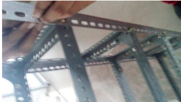
Gambar 29. Perakitan besi siku rak spare part
