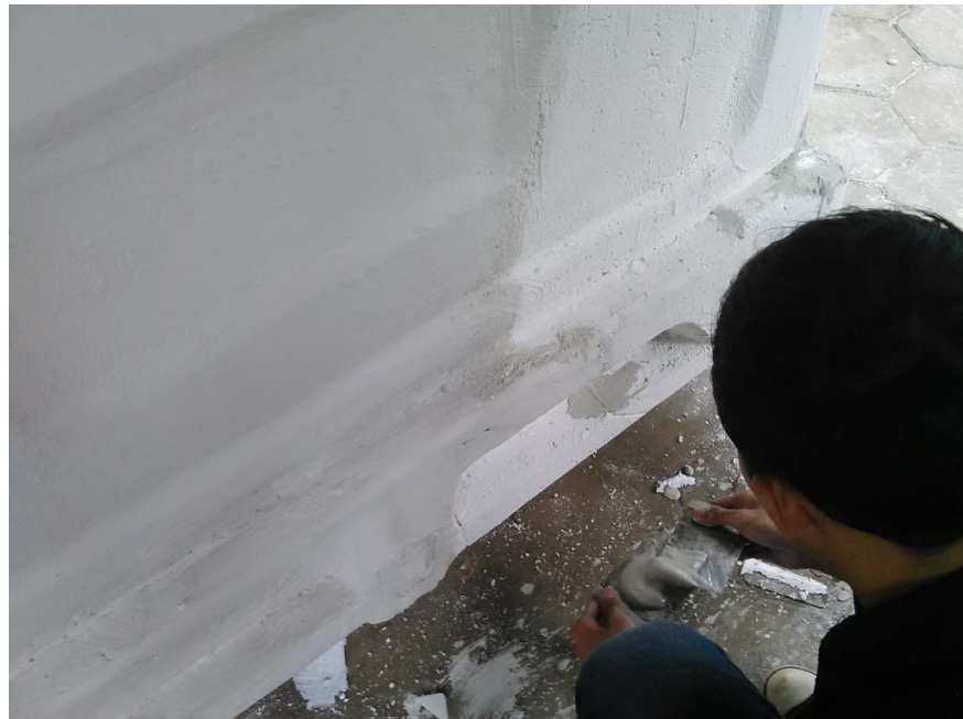
Gambar 22. Melapisi Menggunakan Gypsum
