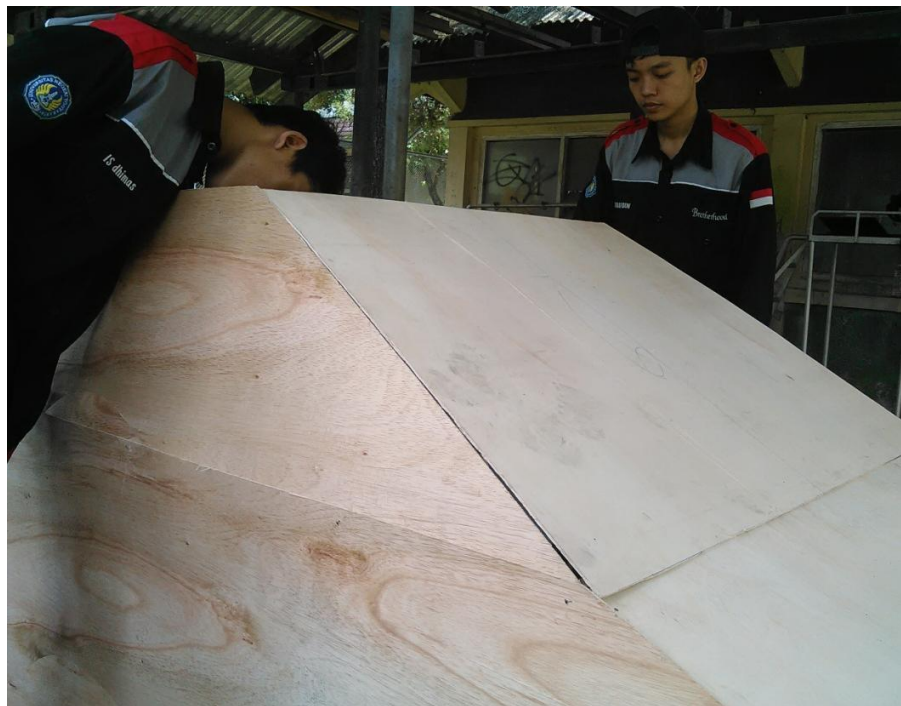
Gambar 20. Pemasangan Triplek Pada Rangka Cetakan
