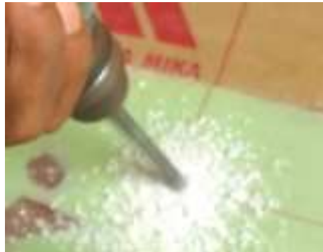
Gambar 71. Proses pengeboranudukan nozle.
