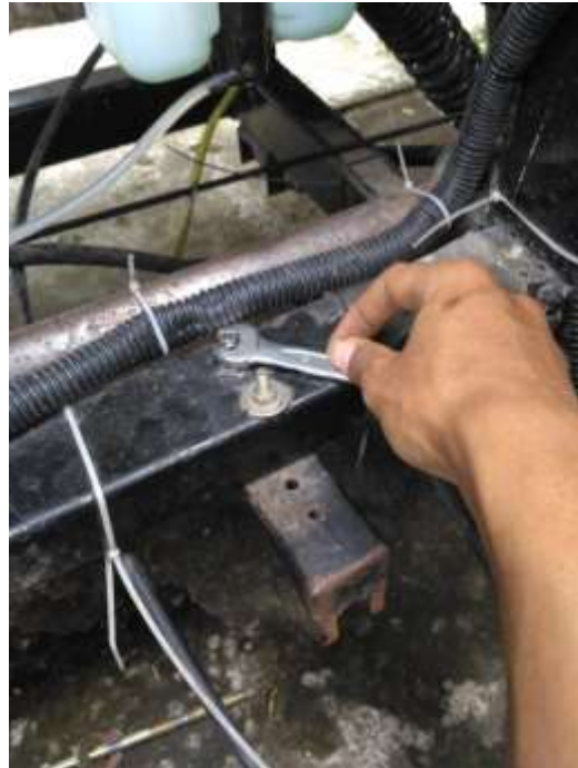
Gambar 27. Proses pemasanganudukan kabel transmisi
