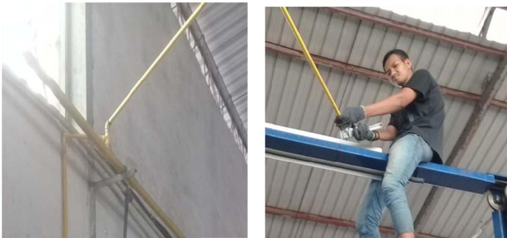
Gambar 19. Proses pemasangan jalur *by-pass* dan pemasangan jalur pipa diatas *stall 1*
