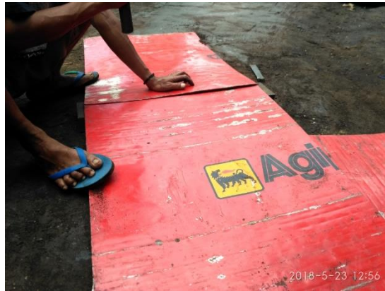
Gambar 47. Proses pemasangan antar lembaran drum bekas
