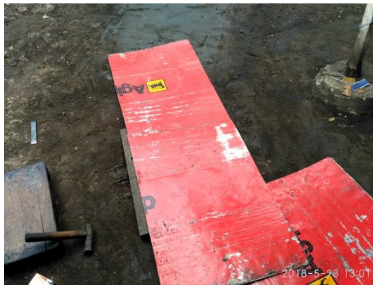
Gambar 48. Hasil pemasangan drum yang telah direkatkan
