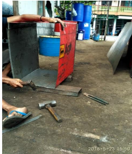
Gambar 51. Proses pelipatan untuk pemasangan kawat
