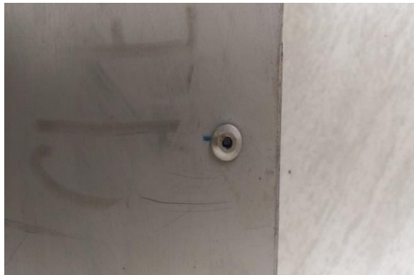
Gambar 33. Perivetan besi holo dengan triplek.
