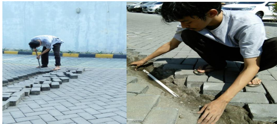
Gambar 36. Proses pemasangan instalasi listrik dibawah tanah.
