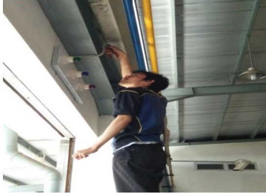
Gambar 35. proses pemasangan papan lampu Indikator.
