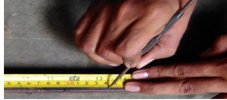
Gambar 25. Pengukuran Besi Hollow
