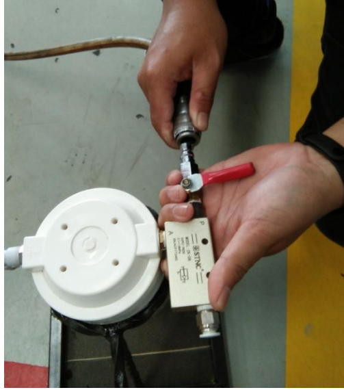
Gambar 38. Pemasangan Selang Kompresor
