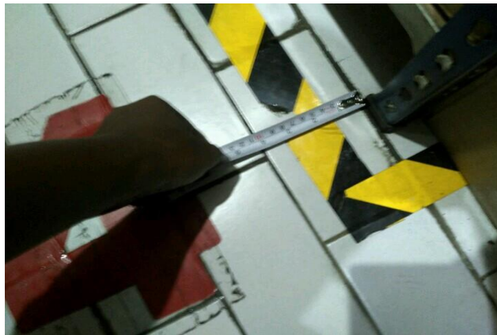
Gambar 4.22. Pengukuran jarak pemasangan garis keselamatan
