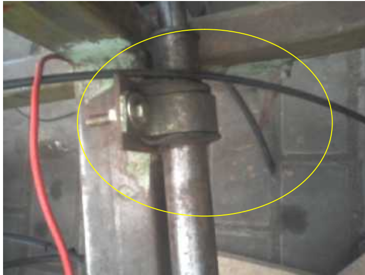
Gambar 38. Hasil Dudukan Rack Housing Bagian Kanan Yang Sudah Terpasang
