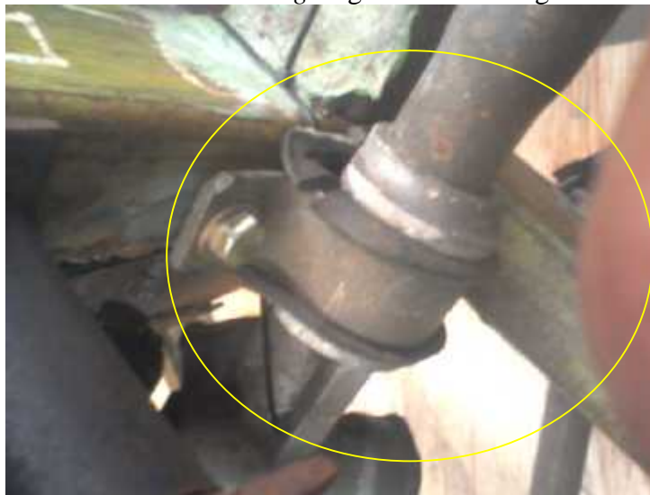
Gambar 39. Hasil Dudukan Rack Housing Bagian Kiri Yang Sudah Terpasang
