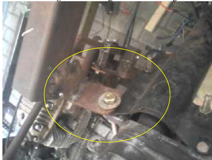
Gambar 37. Hasil Dudukan Steering Column Bagian Atas Yang Sudah Terpasang
