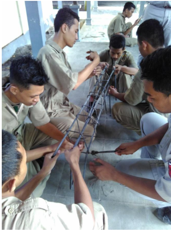
Gambar 6. Praktik merangkai besi tulangan balok
