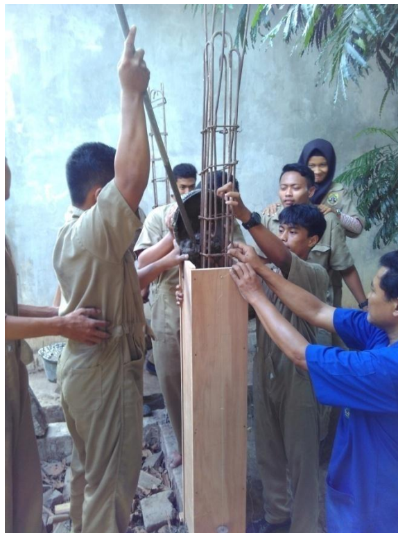
Gambar 7. Praktik ketrampilan mengecor kolom
