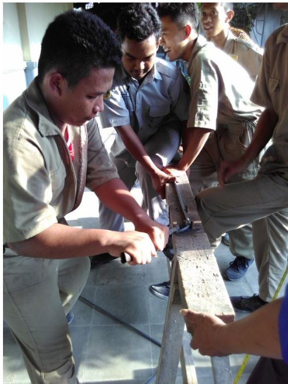
Gambar 5. Praktik ketrampilan menekuk besi tulangan pokok
