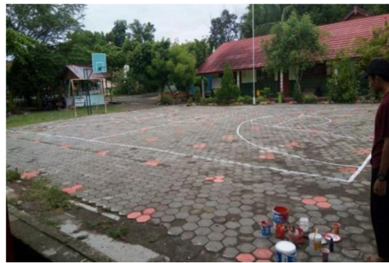
Pengecatan Garis Lapangan
