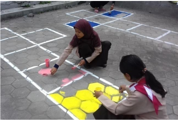
Pengecatan Area Bermain
