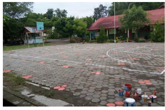
Pengecatan Garis Lapangan
