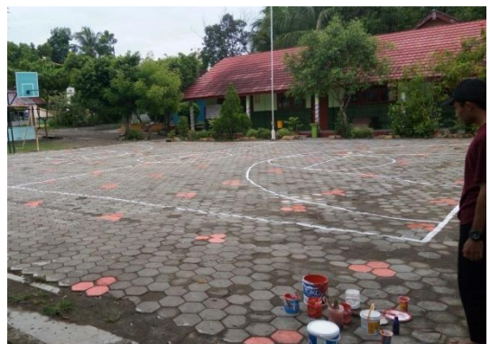
Pengecatan Garis Lapangan
