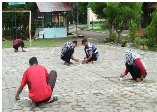
Pengecatan Garis Lapangan
