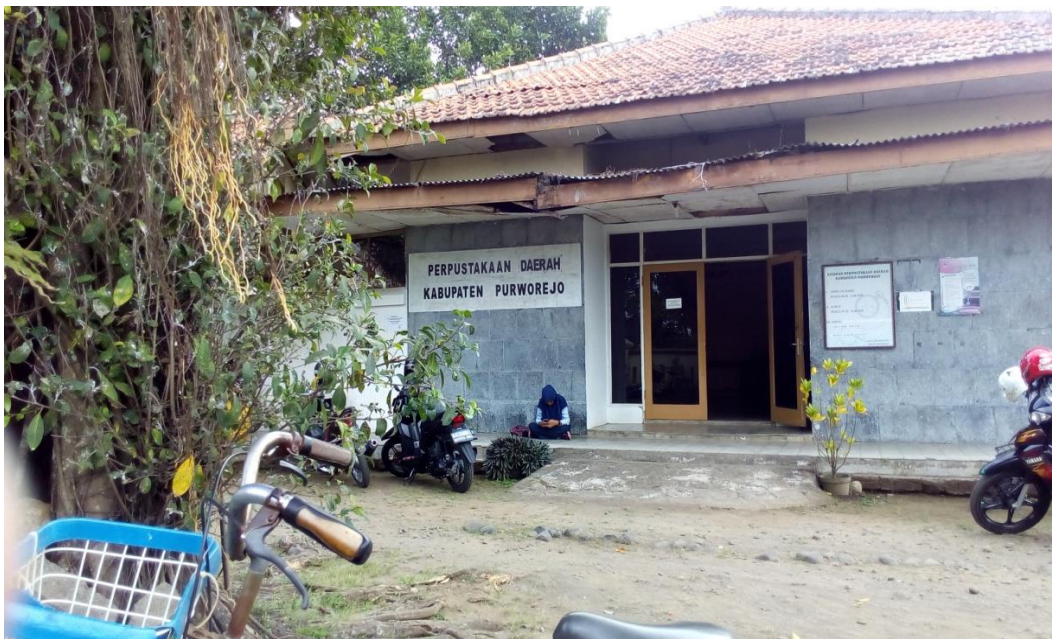
Gambar 4. Gedung Perpustakaan DINASARPUS
