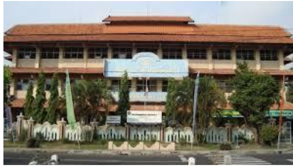
Gambar 1. Gedung SMK Muhammadiyah 3 Yogyakarta Tampak Depan
