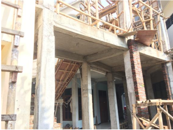
Masjid SMA N 1 Magelang (sedang dalam proses renovasi)
