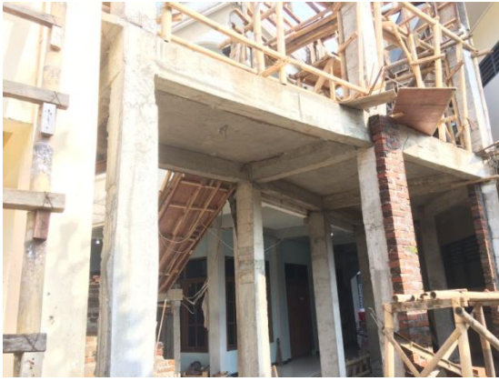
Masjid SMA N 1 Magelang (sedang dalam proses renovasi)
