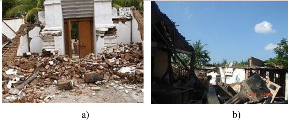
Gambar 14. Dampak gempabumi Yogyakarta. a) Bangunan dikompleks makam imogiri roboh. b) rumah di wilayah kecamatan Jetis roboh (wikipedia.com)
