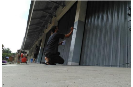
Pengecatan Pintu Bengkel
