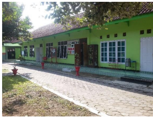
Gambar 1. Ruang Kantor Guru
