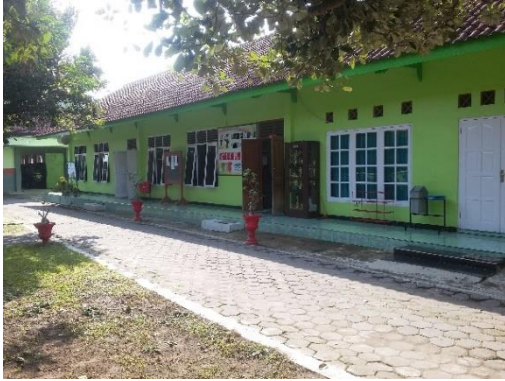
Gambar 3. Ruang Kantor Guru
