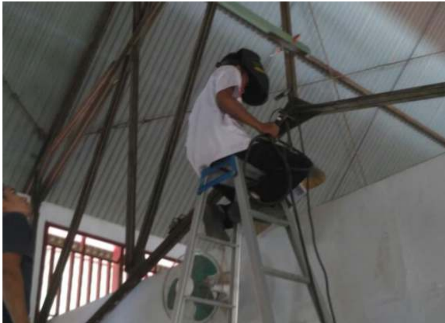
Gambar 13. Pemasangan Kipas Kelas
