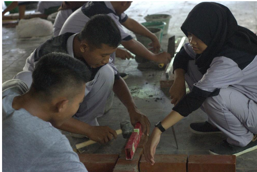
Praktik pemasangan dinding bata persilangan
