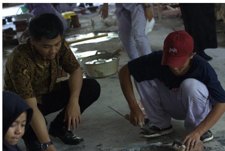
Praktik pemasangan dinding bata siku
