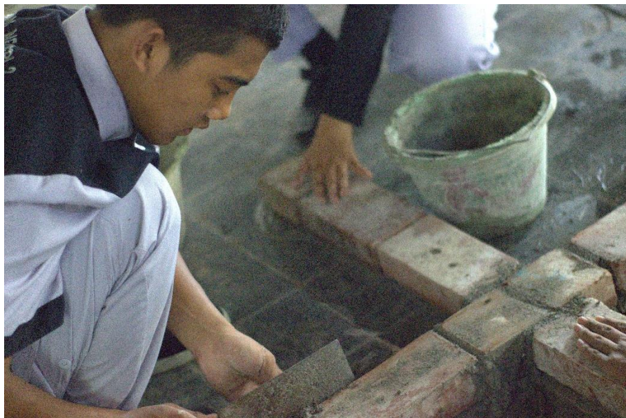
Praktik pemasangan dinding bata persilangan
