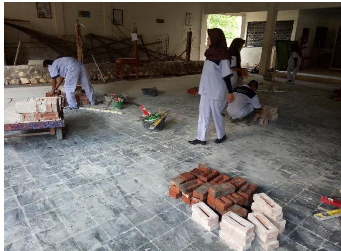
Persiapan praktik pemasangan bata lurus
